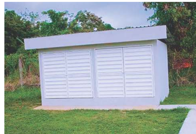
Centro de almacenamiento de desechos, Roatán.
